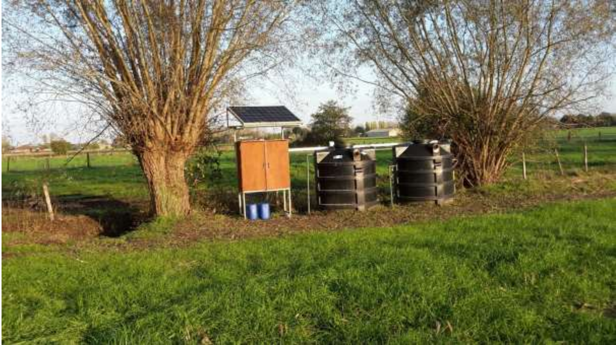
Deze installatie zorgt voor de biologische omzetting van nitraat in het onschadelijke stikstofgas.
