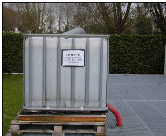
Foto 3: Met een lavafilter en drie bezinkbekkens kan waswater van prei gemakkelijk gezuiverd en hergebruikt worden.
