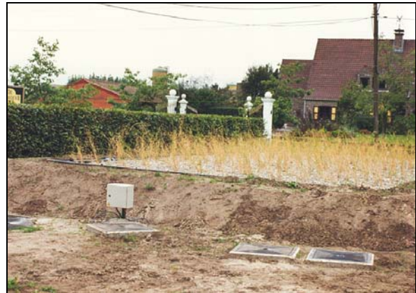
Foto 6: Percolatierietveld kort na de aanleg
