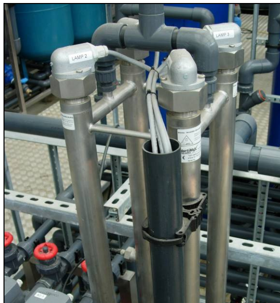
Figuur 2: Lage druk UV-ontsmetting
